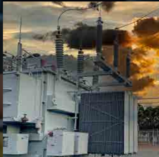
SYSTEME D'ALARME DE TEMPERATURE A DISTANCE
