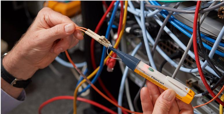
Vérifier la polarité et le fonctionnement des cordons de raccordement.
