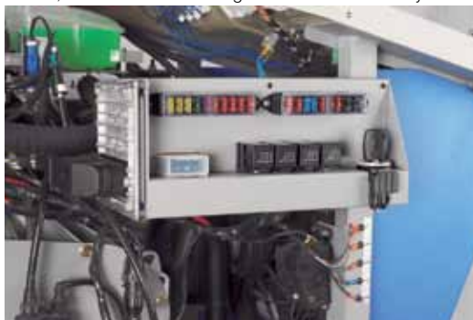
Relais, fusibles et anti-démarrage PAST utilisés dans le système.
