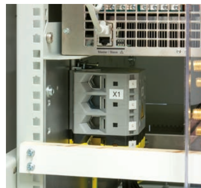
Bornier d'entrée AC / AC input terminal
