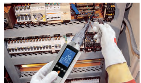
Test de DDR sur tableau avec adaptateur M-952271
